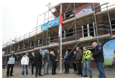
Hoogste punt van de bouw van de Markieshof Helmond
