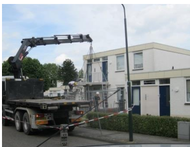
Vervanging van de betontrap bij appartementen in Budel
