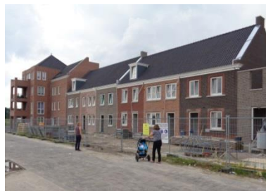
Koopwoningen in VariaVeste Helmond in aanbouw
