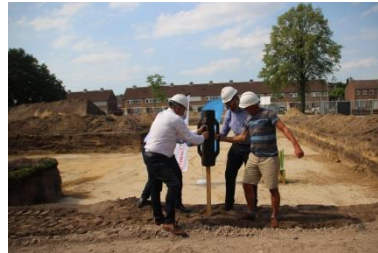
23-6: Start bouw De Sijl Someren
