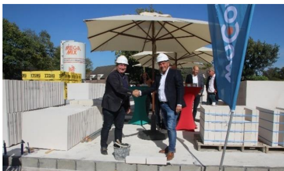
Start bouw Gildeplein, Lierop
