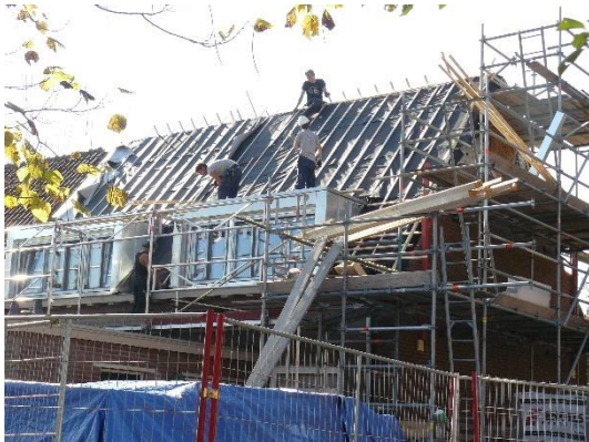
Verduurzaming bij planmatig onderhoud
